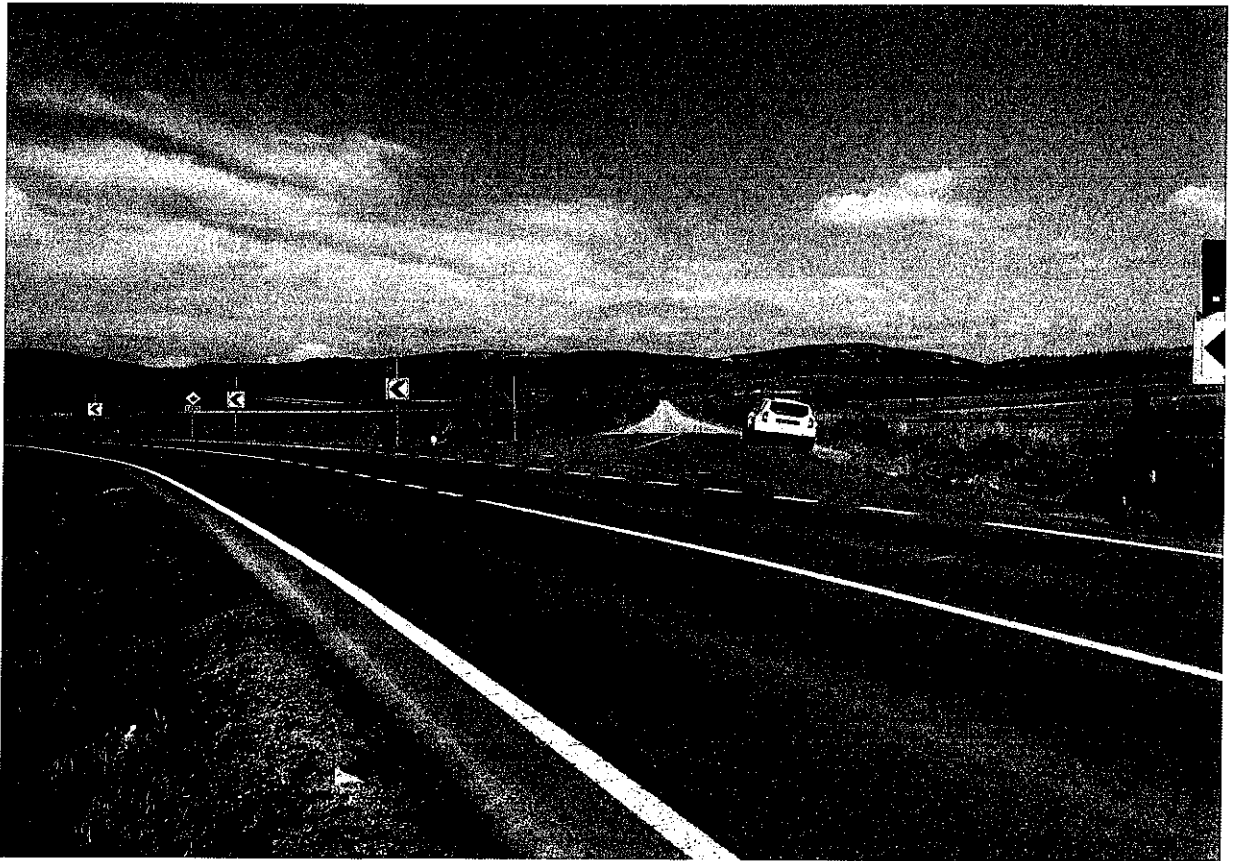
Vedere de pe drumul national DN12, in sensul kilometrajului (spre Toplita), cu drumul DJ 128care se desprinde in dreapta.
