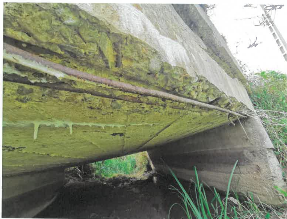
Fig.7- Vederi din aval.
