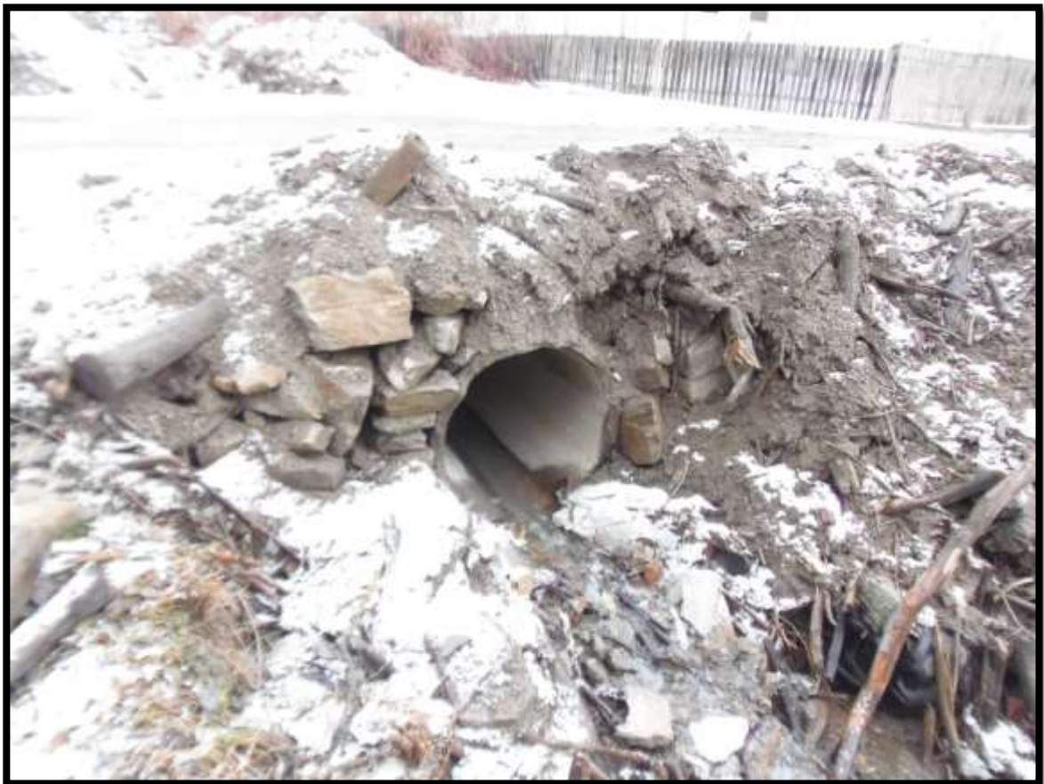
Foto. 2 – Vedere podeț aval
