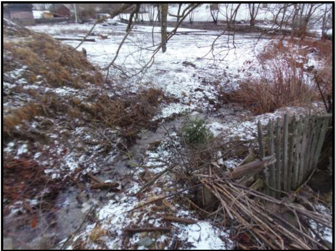
Foto. 4- Vedere abile aval podeț
