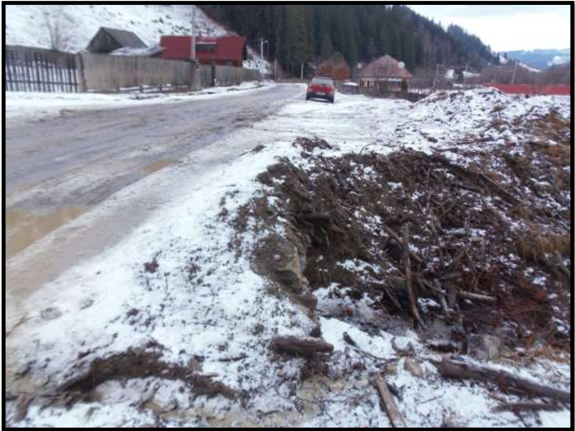
Foto.5 – Vedere cale pe podeț catre Tulgeș
