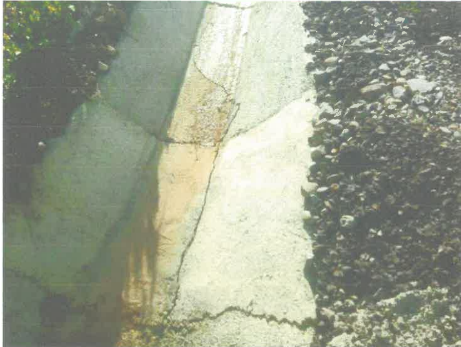
Vedere prin interiorul podețului, zonă de rupere în apropiere de axul drumului, coincide cu aliniamentul fisurii de la suprafața drumului
