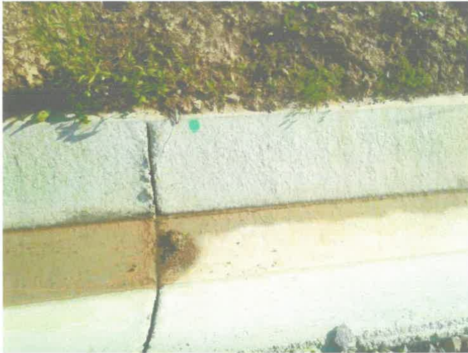
Fisură longitudinală în zona axului drumului, în imediata vecinătate a podețului
