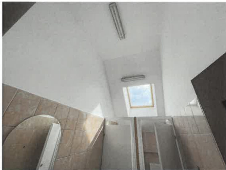
Foto 4 – Vedere plafon grup sanitar
