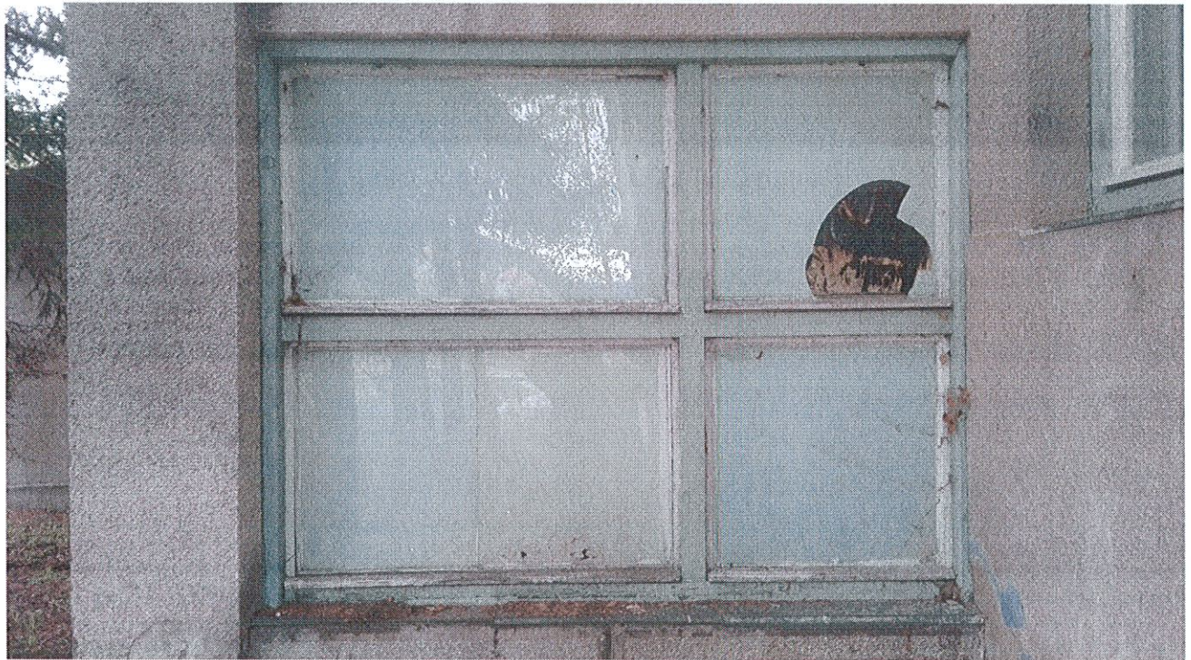
geamul din partea stânga (sub palier) (vedere din exterior)
