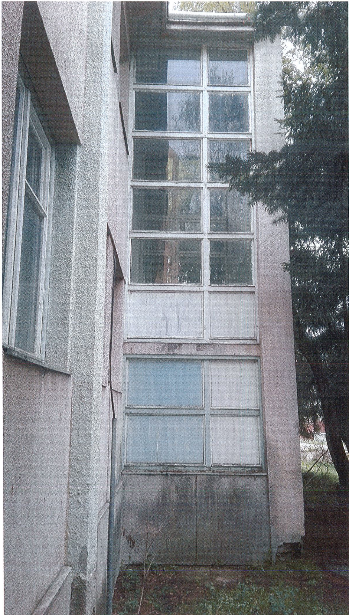
geamul din partea dreaptă (vedere din exterior)
