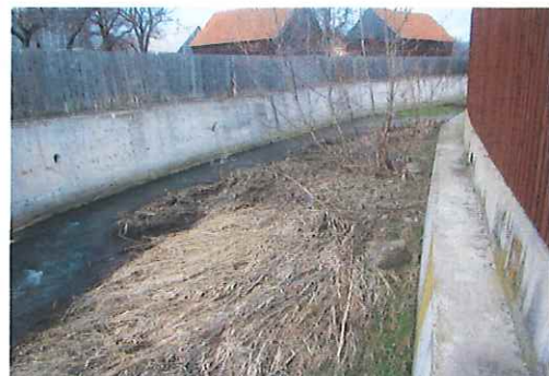
Foto nr. 10: Vedere spre amonte. Curgerea se realizeaza numai pe malul drept-indiguit. Depuneri de material solid. Cursul apei este indiguit cu ziduri din beton.
