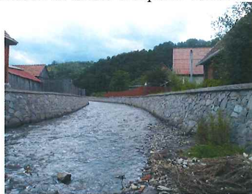
Foto nr. 8: Vedere amonte. Albia raului Olt este regularizata. Malurile sunt indiguite cu ziduri de sprijin din zidarie din piatra bruta rostuita cu mortar de ciment.
