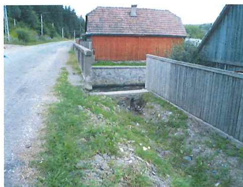
Foto nr. 6: Vedere spre mal stang amonte. Santul de colectare a apelor pluviale de pe platforma drumului debuseaza in albia Oltului.
