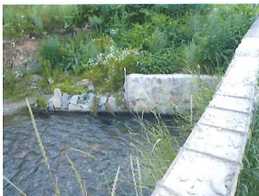
Foto nr. 5: Vedere mal stang-aval. Se continua lucrarile pentru protectia si regularizarea malului stang aval.
