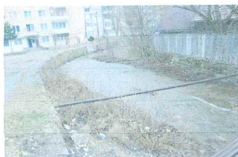
Foto nr. 11: Vedere spre aval. Malul stang si alul drept, indiguit cu zid de sprijin din zidarie cu piatra bruta, rostuita cu mortar de ciment.
