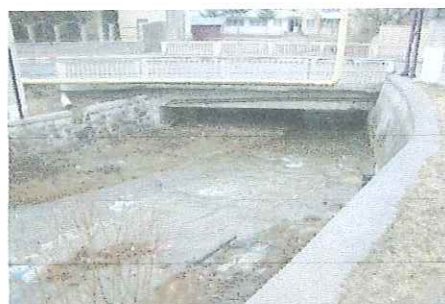
Foto nr. 8: Vedere de ansamblu din amonte. Digul de aparare mal drept este din beton de ciment, iar digul de pe malul stang este din zidarie de piatra cu mortar de ciment.
