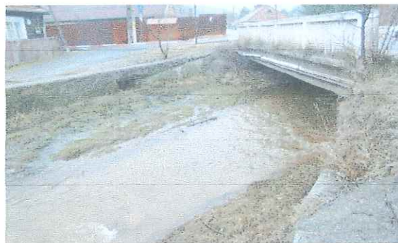
Foto nr. 8: Vedere albie aval. Regularizarea aval cu ziduri de sprijin din zidarie de piatra bruta rostuita cu mortar de ciment.
