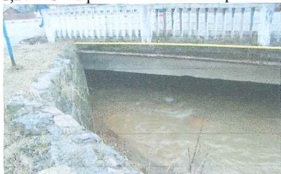
Foto nr. 3: Vedere din amonte. Racordarile cu terasamentul sunt in continuarea zidurilor de protectie ale albiei. Conducta de gaze si telecom pe pod.
