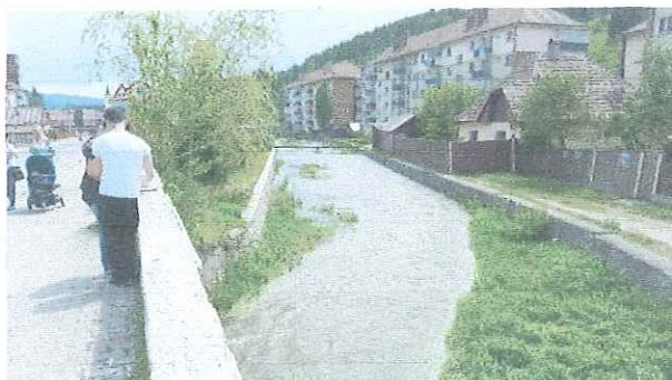
Foto nr. 5: Vedere spre aval. Malurile regularizate, cu ziduri de zprijin din zidarie cu mortar de ciment. Trotuar placat cu pavele autoblocante.
