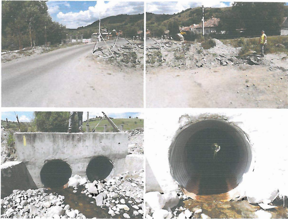
Fig. 09 Situația existentă pe amplasamentele investigate
