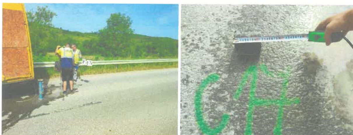
Fig. 17. Execuție carote în mixtura asfaltică sau rigolă betonată
